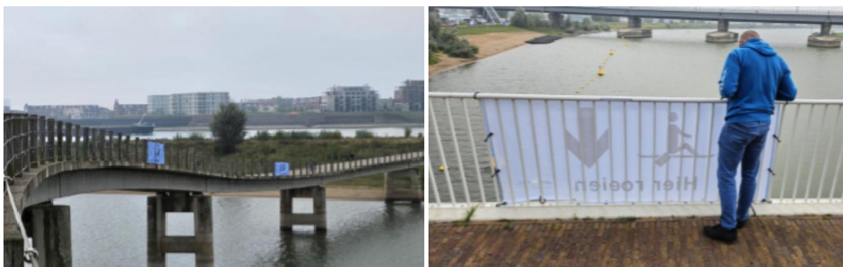
Emplacements des panneaux sur la Spiegelwaal. Source : Municipalité de Nimègue
